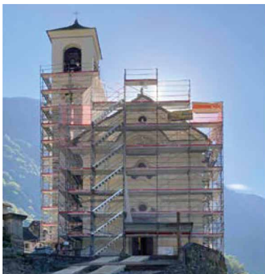
Die eingerüstete Pfarrkirche Maria der Engel im Verzascatal
